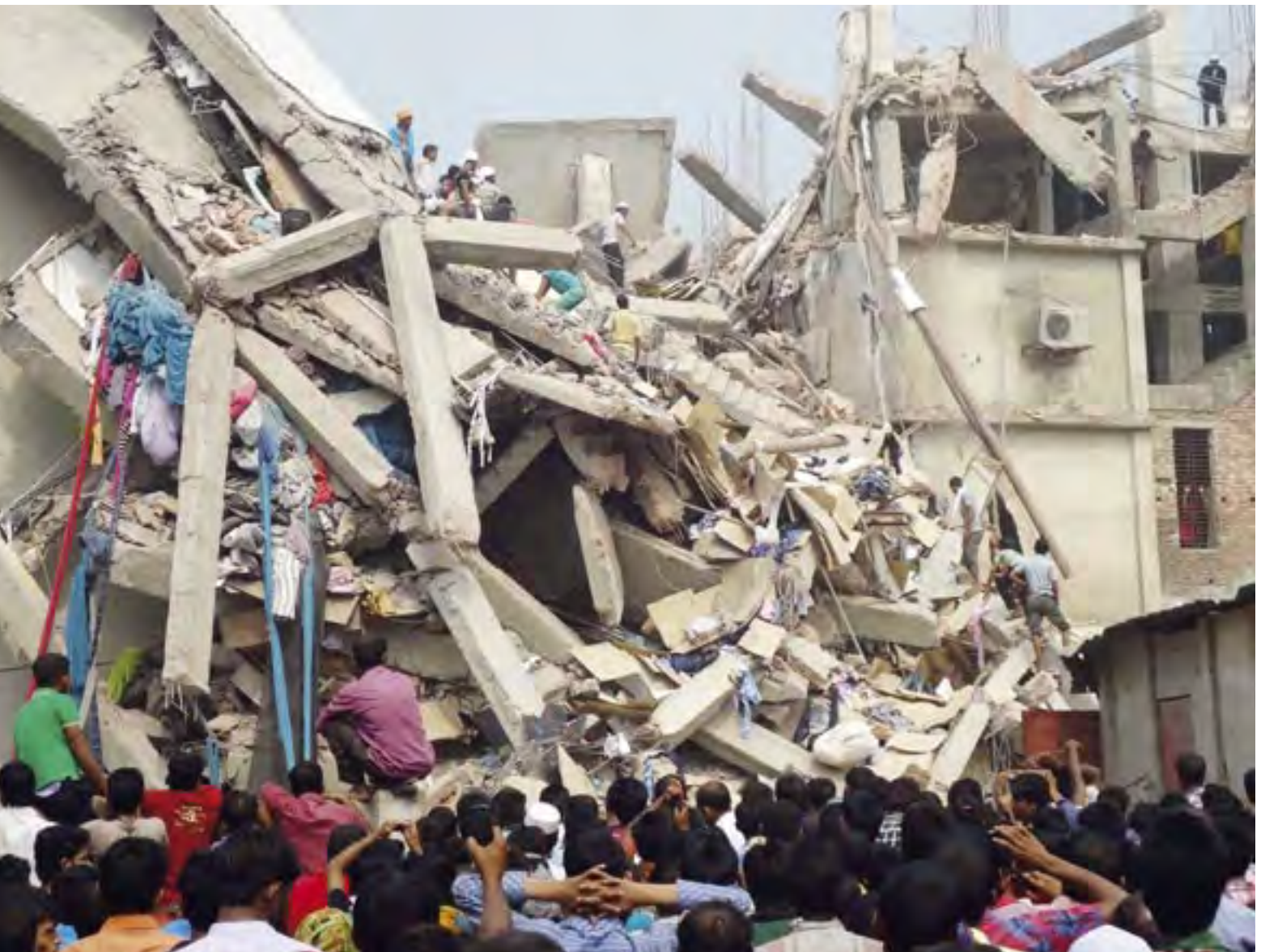
Beim Einsturz des Fabrikgebäudes Rana Plaza in Sabhar am 24. April 2013 wurden 1.135 Menschen getötet und 2.438 verletzt.
